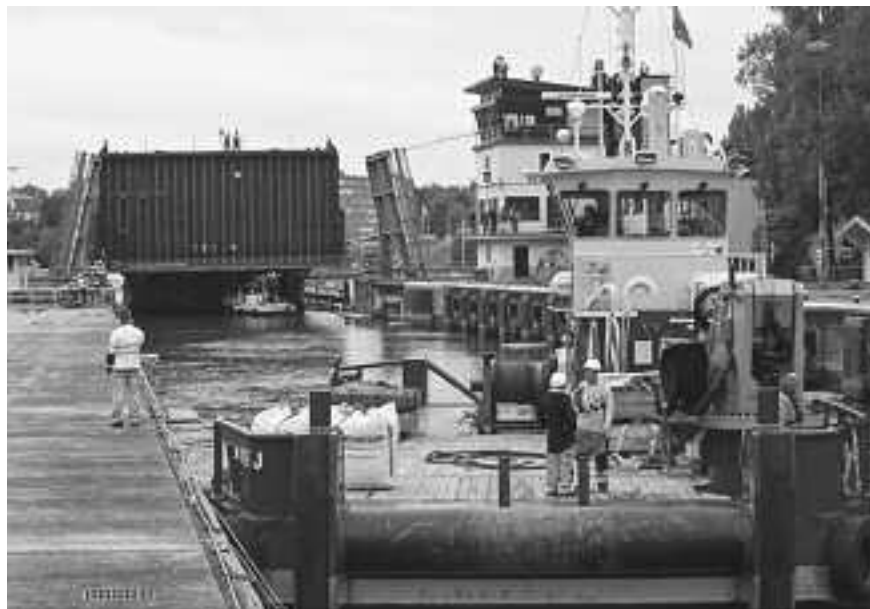
Så här såg det ut när stålskalet från Tallin transporterades genom Södertälje kanal på väg till Ulvsunda och Hovgårdsfjärden. Eftersom stålskalet var något bredare än slussen, transporterades det upphöjt på en pråm.
